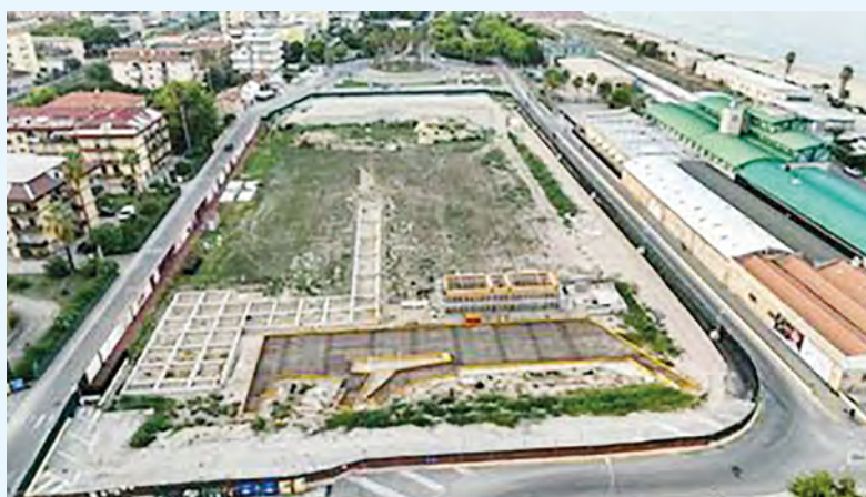
I lavori in corso allo stadio ex Ballarin
